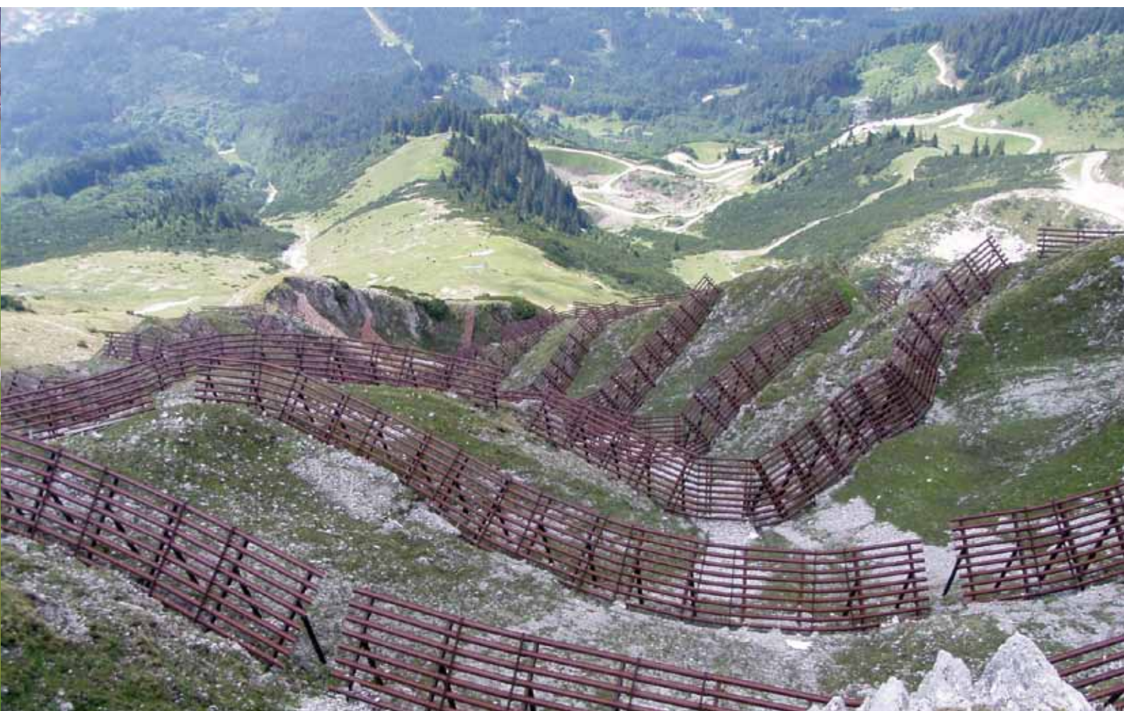
... bis zum Berggipfel - Lawinerverbauung am Rastboden
