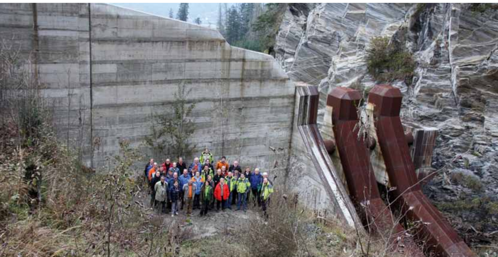
Bauwerk - Mächtige Wildbachsperre im Pinzgau (Salzburg)
