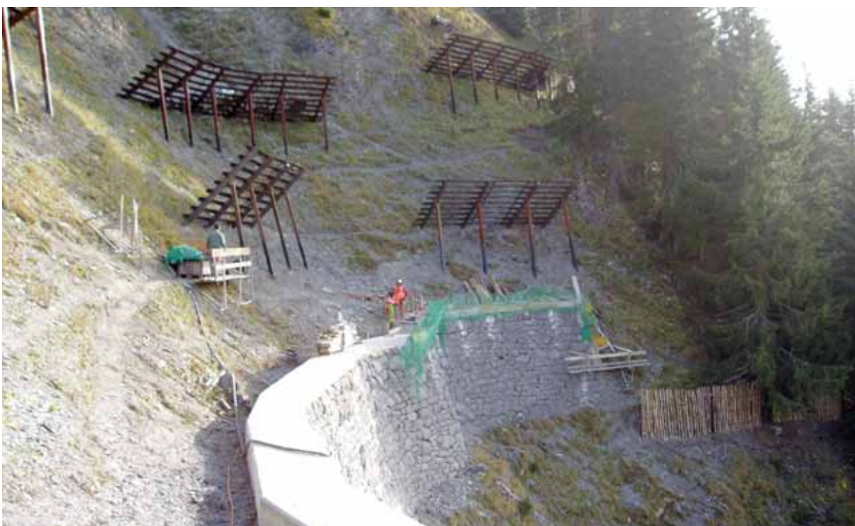
Auf Bewährtem aufbauen - Sanierung der Schutzbauten der Blisadona-Eisenbahnstrecke
