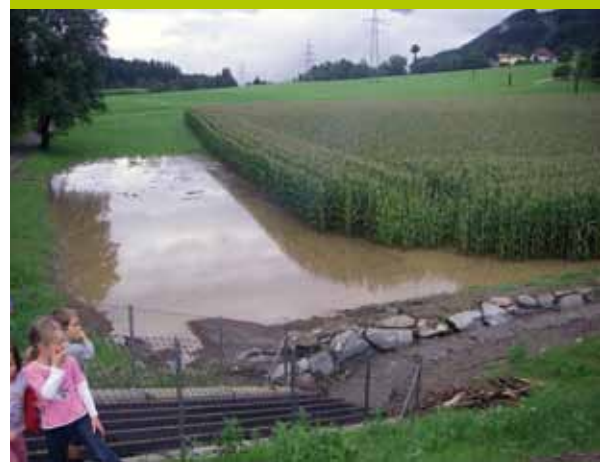
Bewässerung - Rückhaltebecken am Tschierwegerbach
