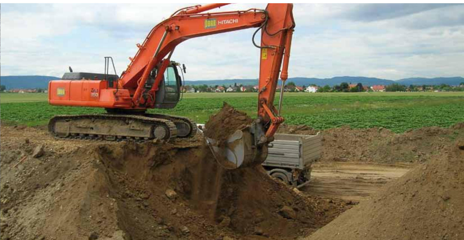
Arbeitsplätze - Bauarbeiten am Kamp (Niederösterreich)
