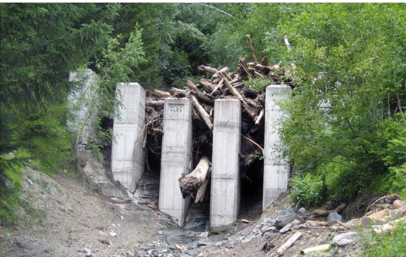
Angefüllt - Murbrecher im Kreuzgraben (Salzburg)
