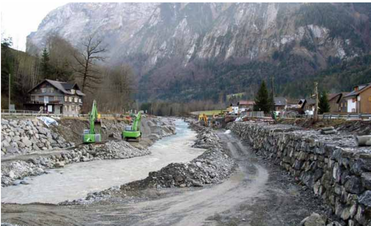
In die Breite - Mehr Abflussraum für die III
