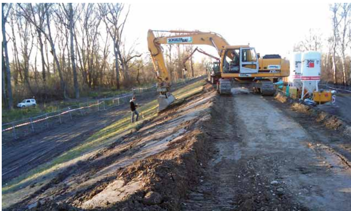
Laufende Verbesserung - Sanierung des Marchfeldschutzdammes
