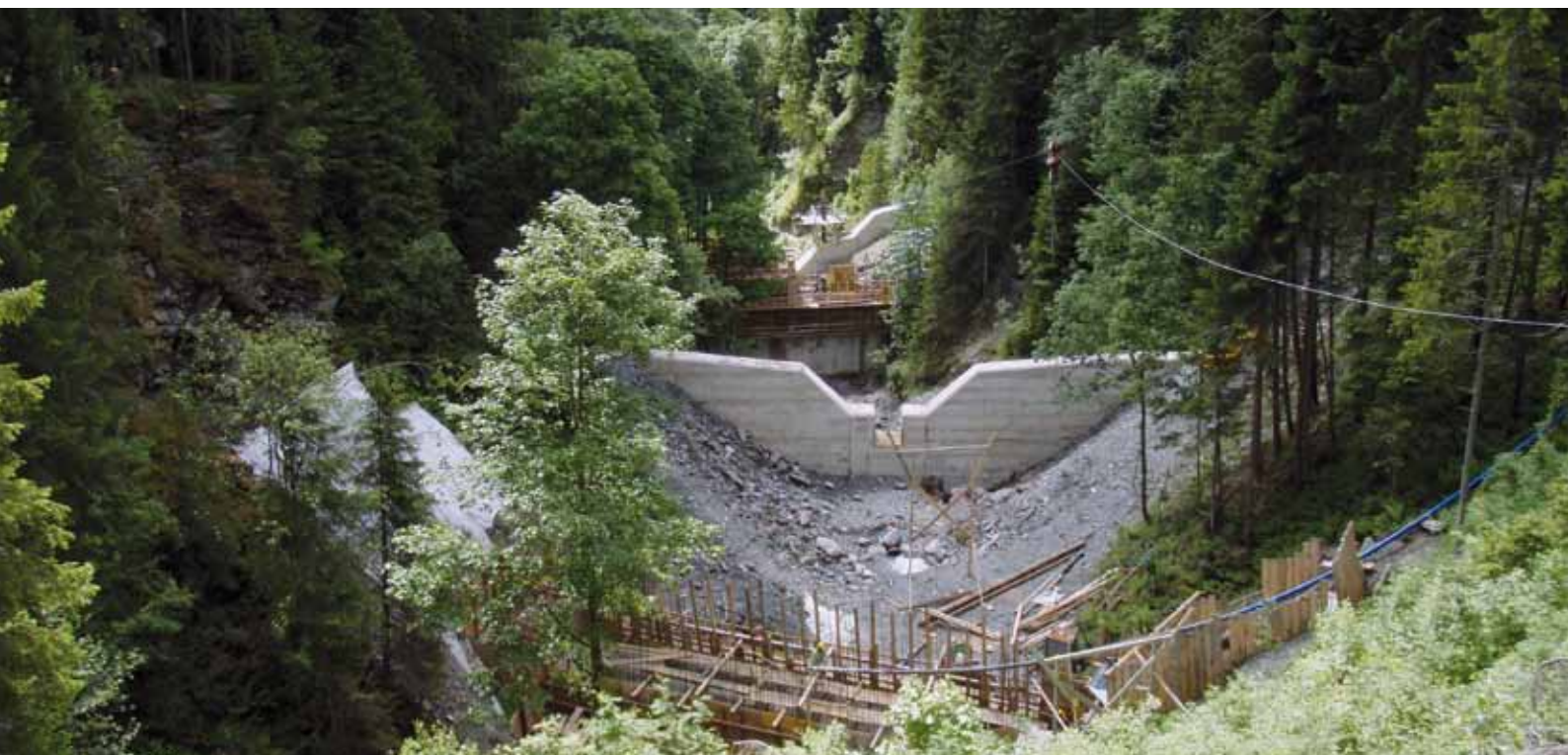
Abgestuft - Geschiebesperren im Saalgraben (Salzburg)
